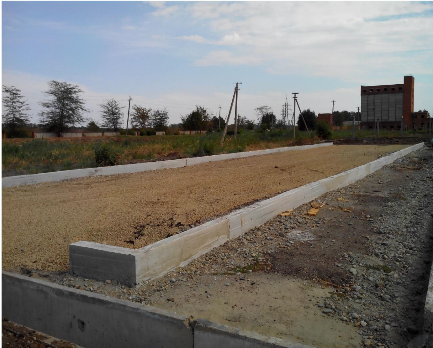
Этап 7- планировка поверхности внутри крольчатника щебнем
