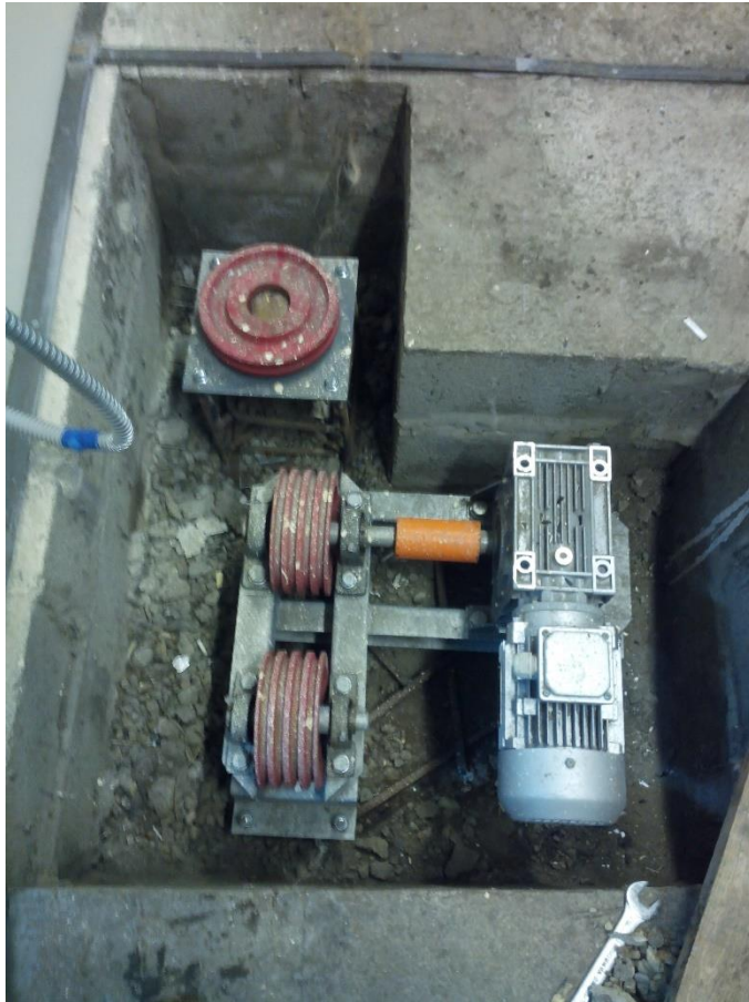
Установка приводной станции с обводным роликом
