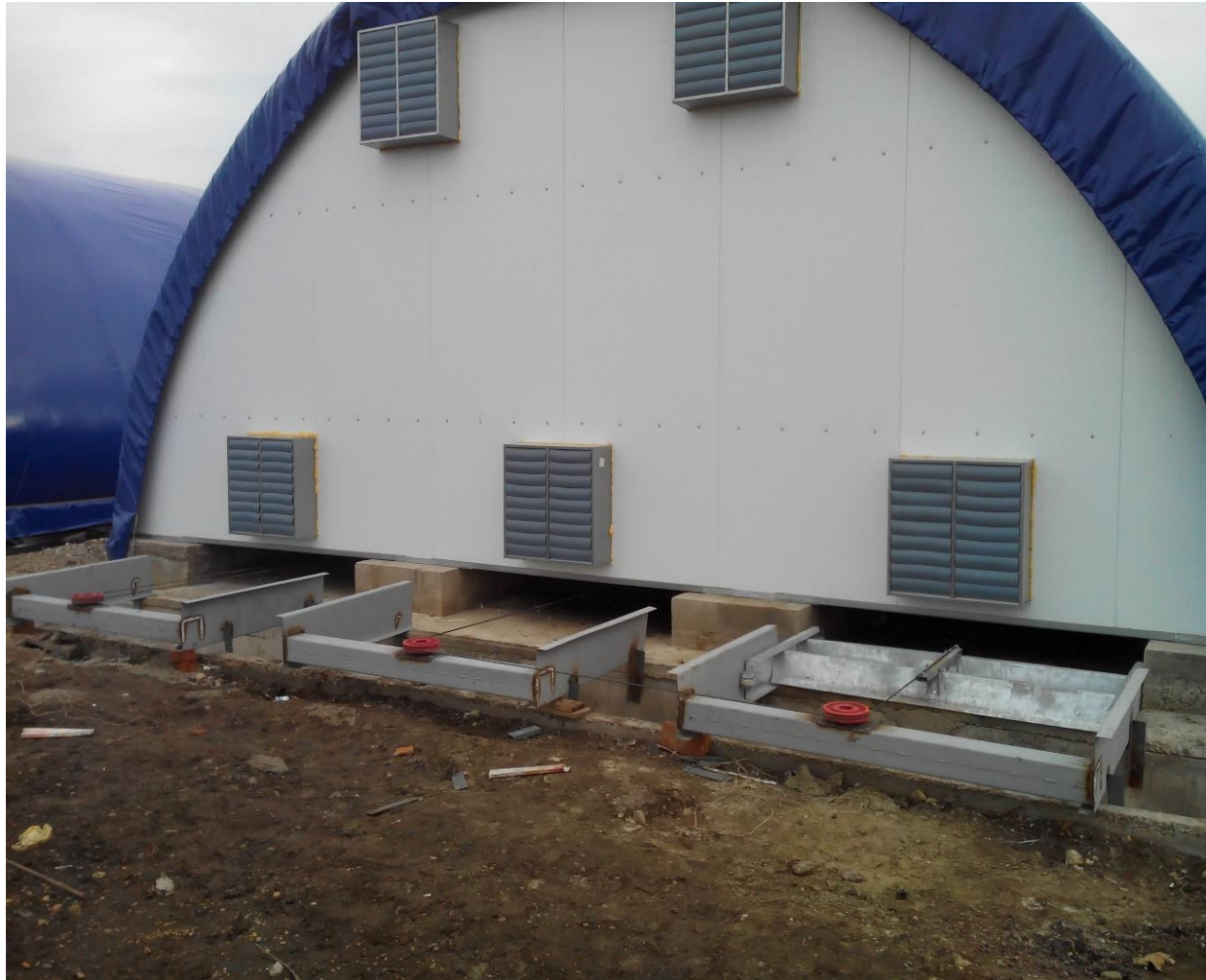
Монтаж вентиляторов
