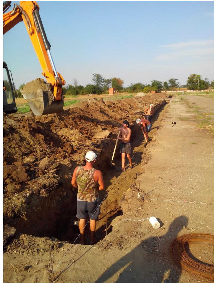
Этап 2- отрывка поперечного навозоудалительного канала
