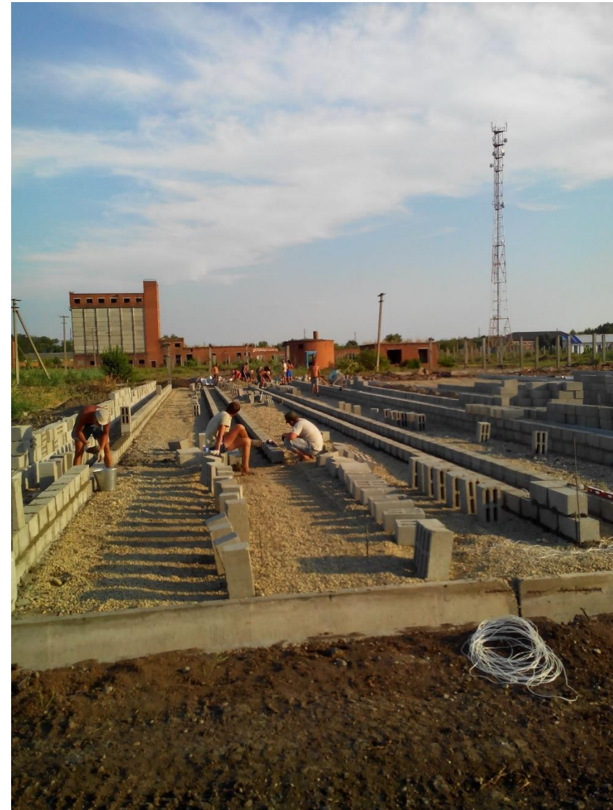
Этап 8 – кладка стен навозоудалительных каналов
