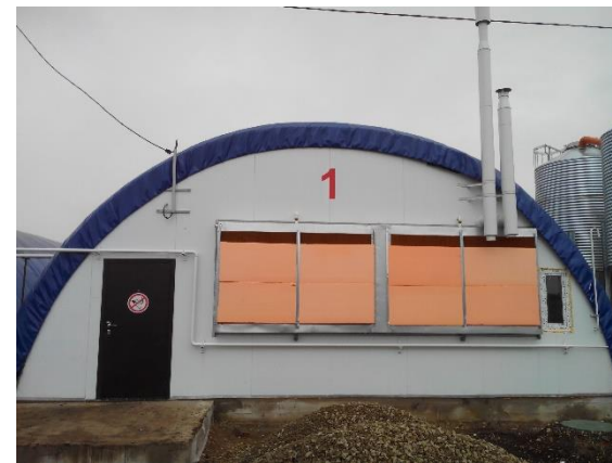
Утепление подкулингов пенофлексом в осенне-зимний период
