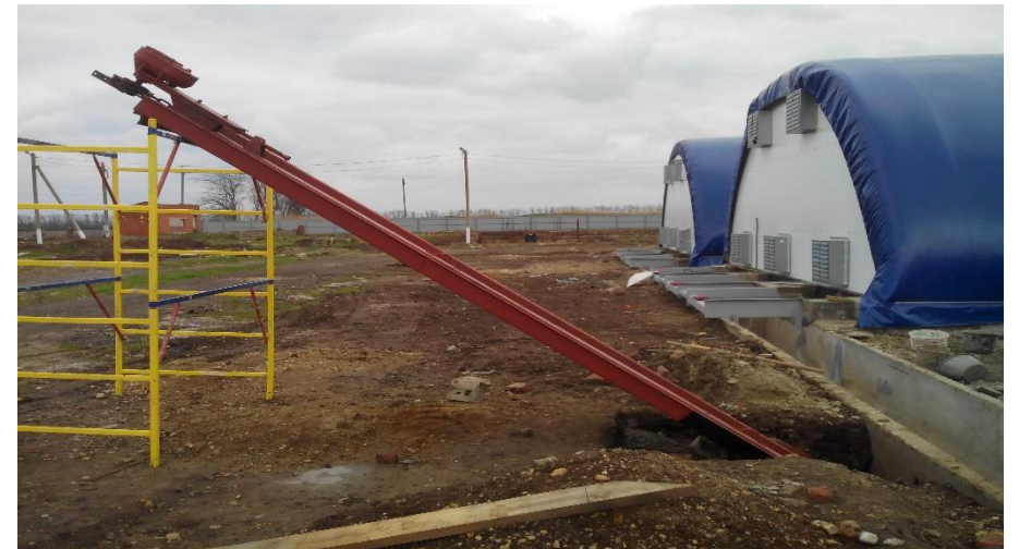
Монтаж наклонного транспортера ТСН-160
