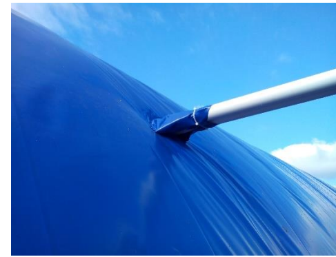
Заделка прорезей в тенте в месте прохождения труб АРК
