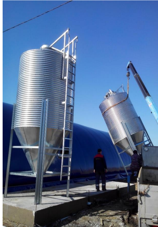
Монтаж загрузочных бункеров
