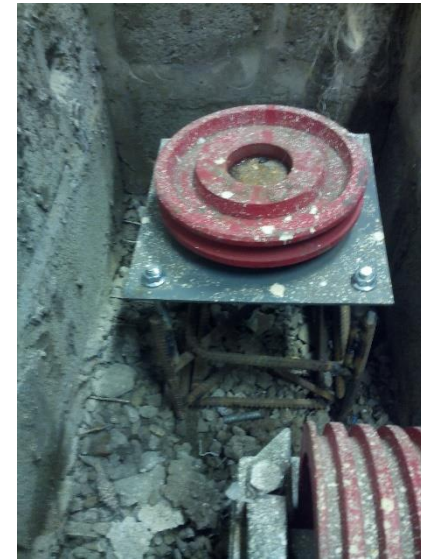
Армирование обводного ролика
