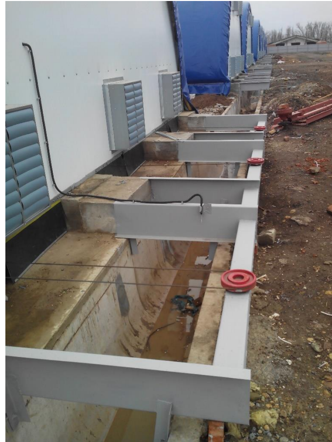
Монтаж наружных рам навозоудаления
