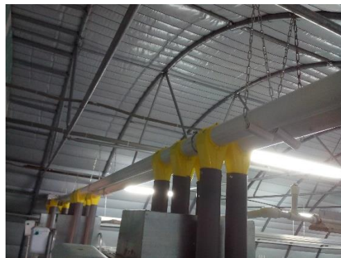
Монтаж поперечной АРК в корпусе
