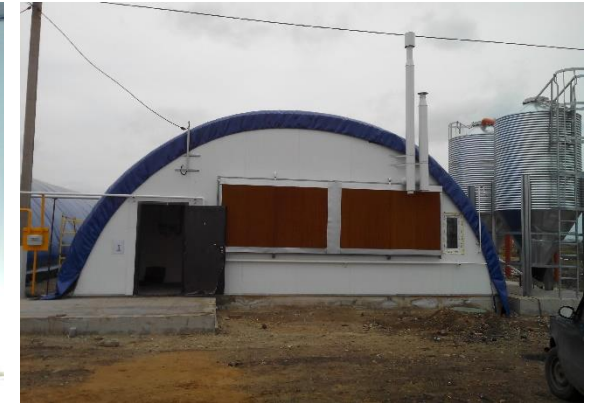
Монтаж подкулингов и зашивка отверстия между ними
