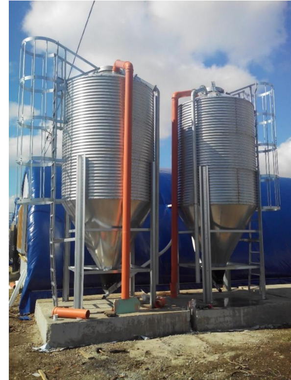
Монтаж вакуумной подачи комбикорма в загрузочных бункерах
