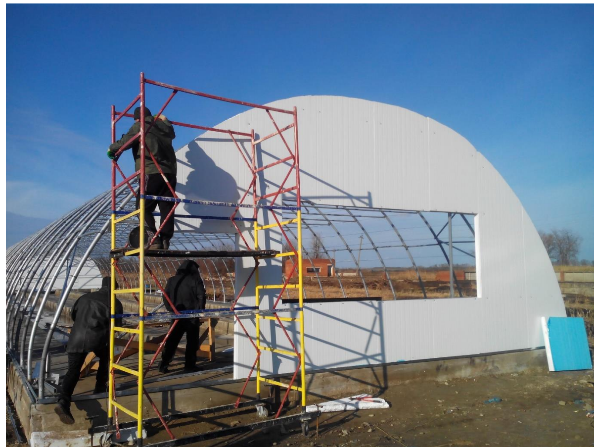
Этап 14 – установка торцов из сэндвич панелей
